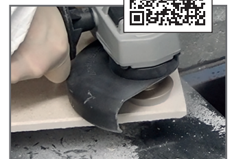
Öffnungen aufweiten / widen openings
